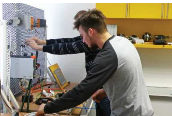
Experimenty so sústavou riadenou pomocou PLC / Experiments with the control system using PLC // Experimente mit der Bauteilgruppe, die mittels PLC gesteuert wird
