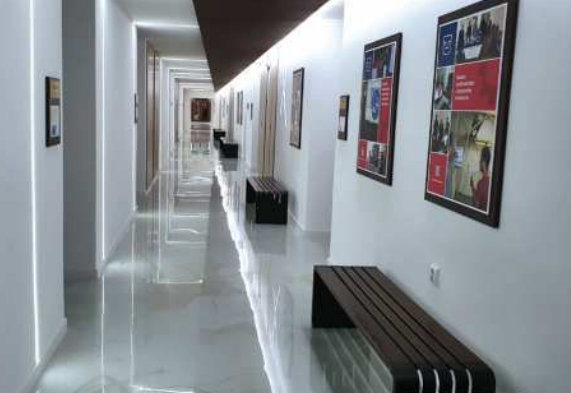
Rekonštrukcia chodby / Corridor reconstruction // Korridorrekonstruktion
