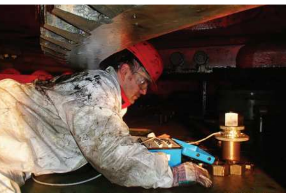
Meranie na liacom stojane / Measurement on the casting pedestal // Messung auf dem Gießständer
