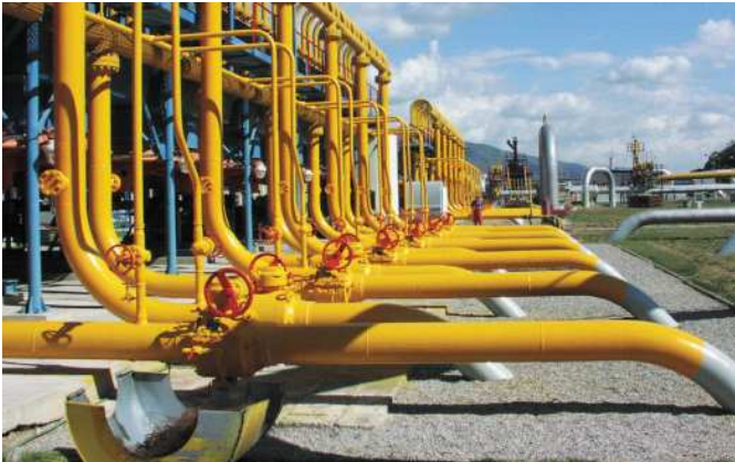
Riešenie kmitania potrubného systému v SPP / Solution of vibrations of the piping system for SPP (Slovak Gas Industry) // Lösung der Schwingung des Rohrsystems in SPP
