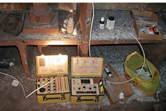
Meranie na stojane konvertora v U.S.Steel / Measurements on the converter pedestal in the U.S.Steel company // Messung auf dem Konverterständer in U.S.Steel
