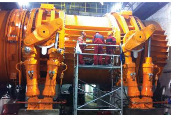
Meranie vo vodnej elektrárni Ružín / Measurements in Ružín hydropower plant // Messung im Wasserkraftwerk Ružín
